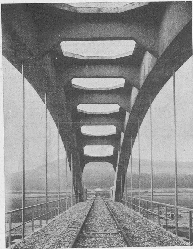
Abb. 4. Blick in die Brücke mit oberem Windverband.
