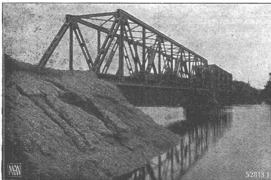
Eisenbahnbrücke über den Bomonokrick (Kamerun).
