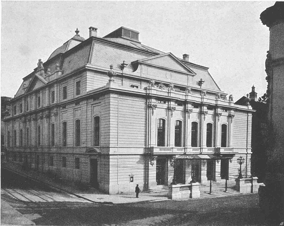
DAS STADTTHEATER IN BASEL ARCH. FRITZ STEHLIN IN BASEL
