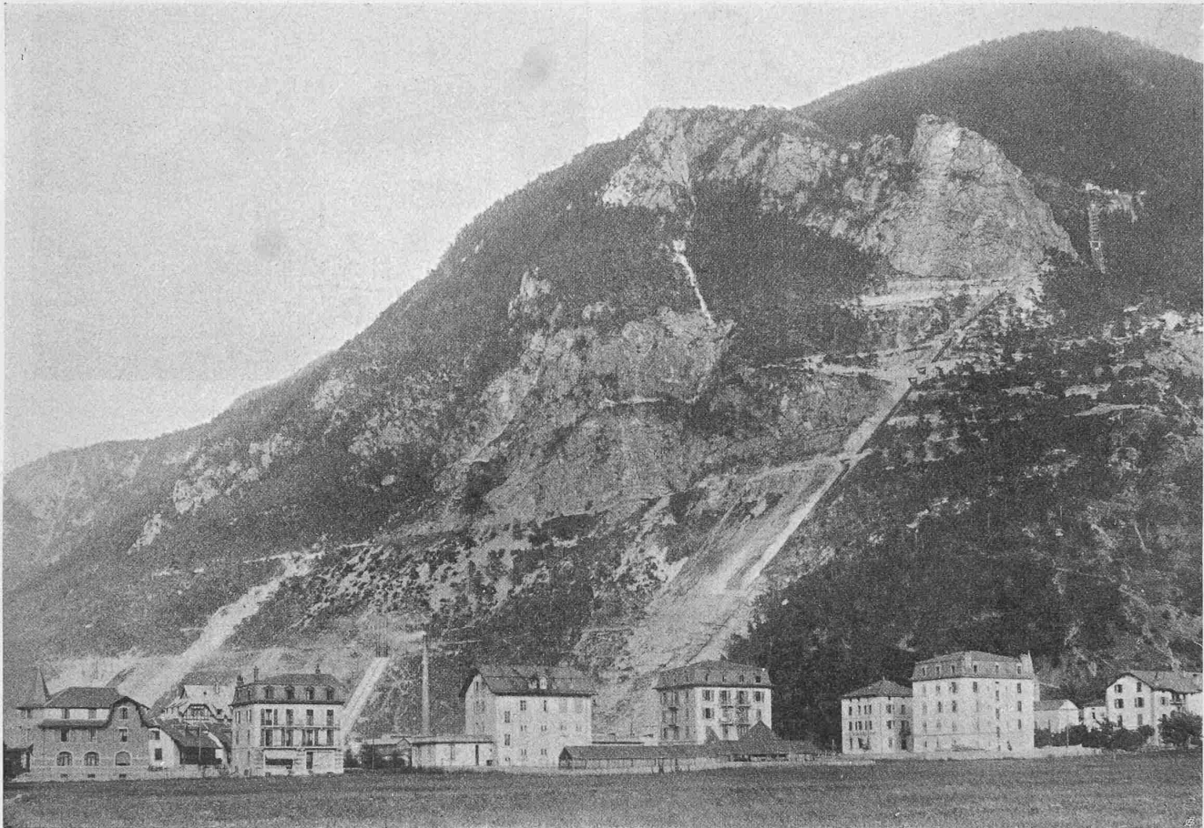
Abb. 15. Uebersicht der ganzen Naviance-Druckleitung (rechts); Druckleitung des Rhone-Werkes mit Standrohren (links).
