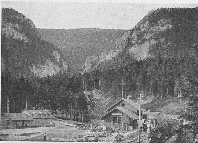
Abb. 6. Station Oberdorf am Südportal des Weissensteintunnels.
