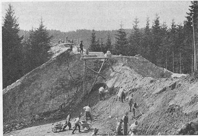
Abb. 17. Rückseite der gerissenen Flügelmauer links (Abb. 16).
