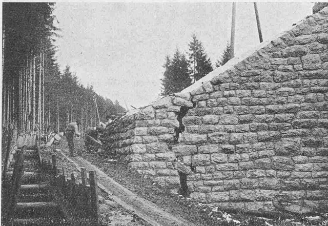
Abb. 14 bis 16. Flügelmauer rechts am 4. III. 08, Gewölbescheitel I am 4. III. 08 und Flügelmauer links am 16. III. 08 am Widerlager I.
