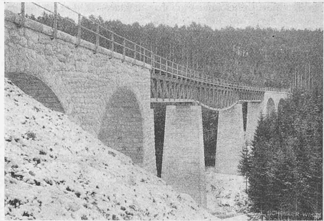
Abb. 9. Geissloch-Viadukt, von S.-W. gesehen.
