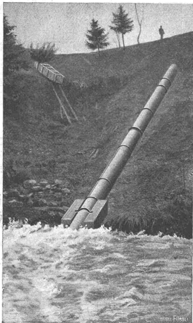
Automatischer Saugüberfall in Gibswil (Kanton Zürich).
