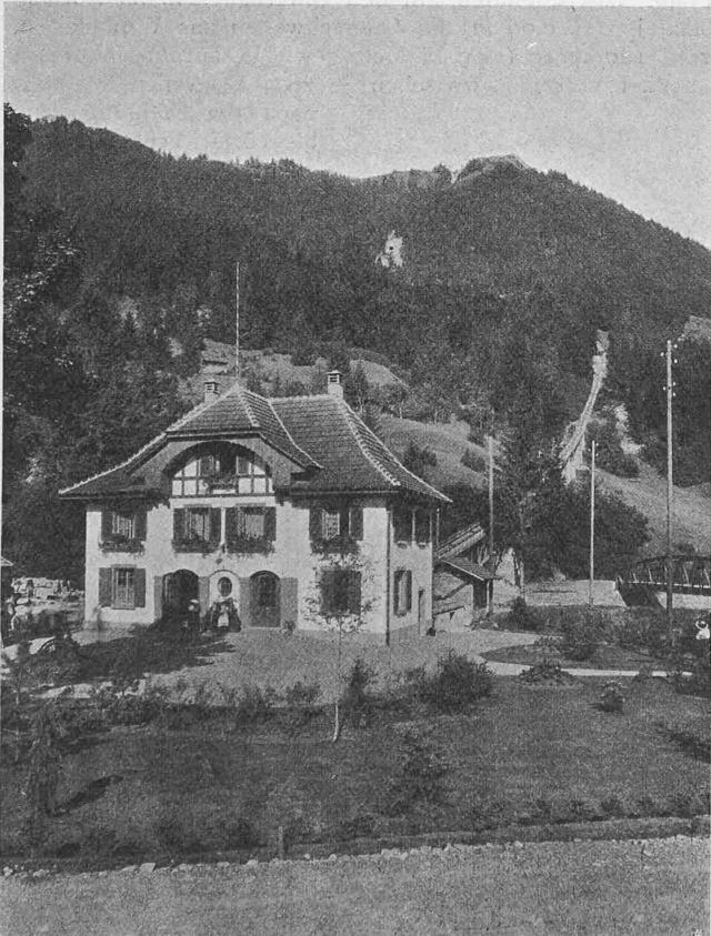
Abb. 7. Stationsgebäude Mülenen und Anfangsstrecke der Niesenbahn.
