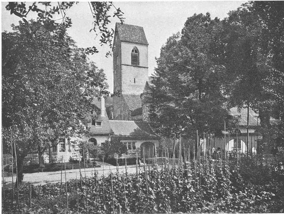
Anschluss des Abwarthäuschens an die alte Stadtmauer, Durchgang zur Kirche
