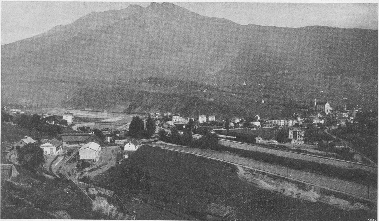
Abb. 24. Ansicht des Installationsplatzes in Naters am Fusse der Südrampe der Lötschbergbahn, mit Blick auf Brig und die Simplonbahn.
