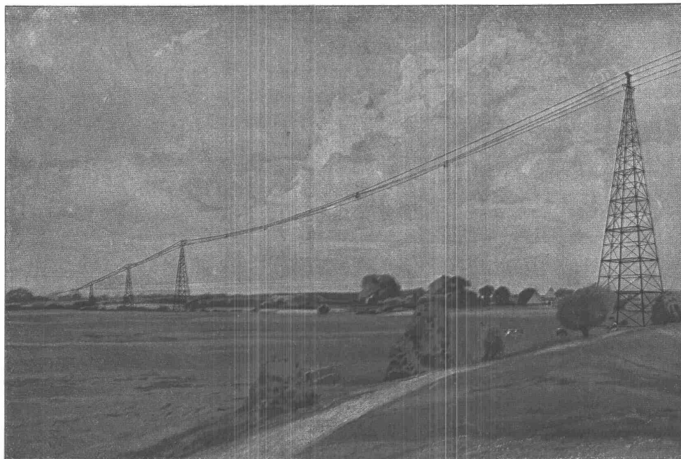
Drahtseilbahn von 13 km Länge zum Transport von Ton für die Alsen'schen Portlandzementfabriken, Hamburg.
