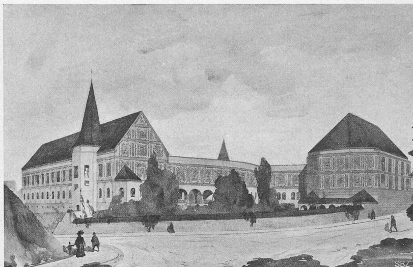
Gesamtansicht der Baugruppe von Süden.
