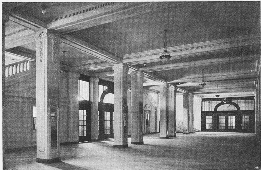
Abb 6. Haupteingang an der Herrengasse und Vestibül.
