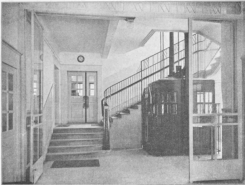
Abb. 9. Das Treppenhaus vom Vorplatz im Erdgeschoss aus.
