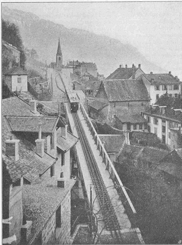
Abb. 28. Chauderon-Brücke und Haltestelle «Les Planches».
