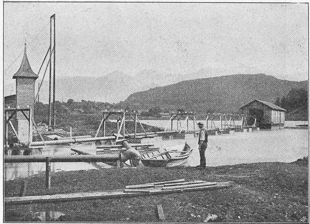
Abb. 48. Schwimmende Rohrleitung vom Baggerschiff zum Wasserschloss.
