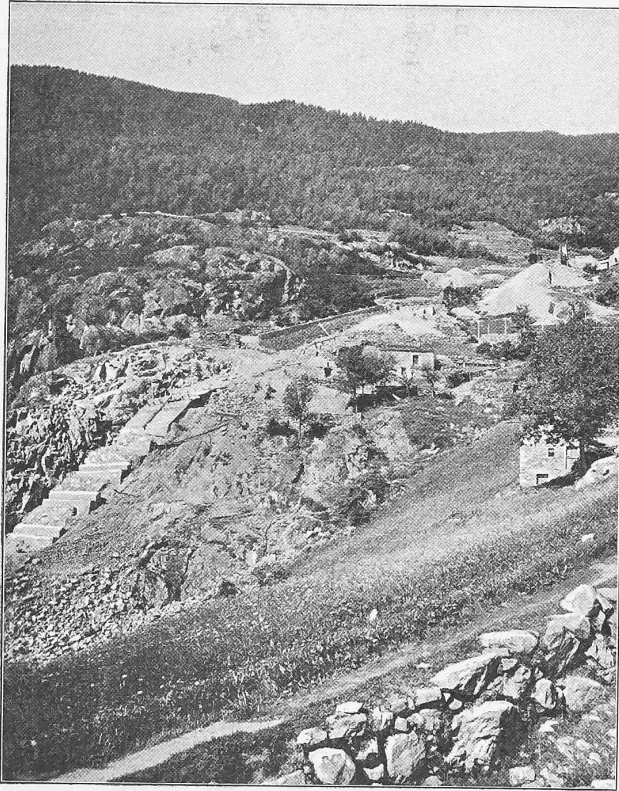
Abb. 25. Mauerfundamente zur Druckleitung.
