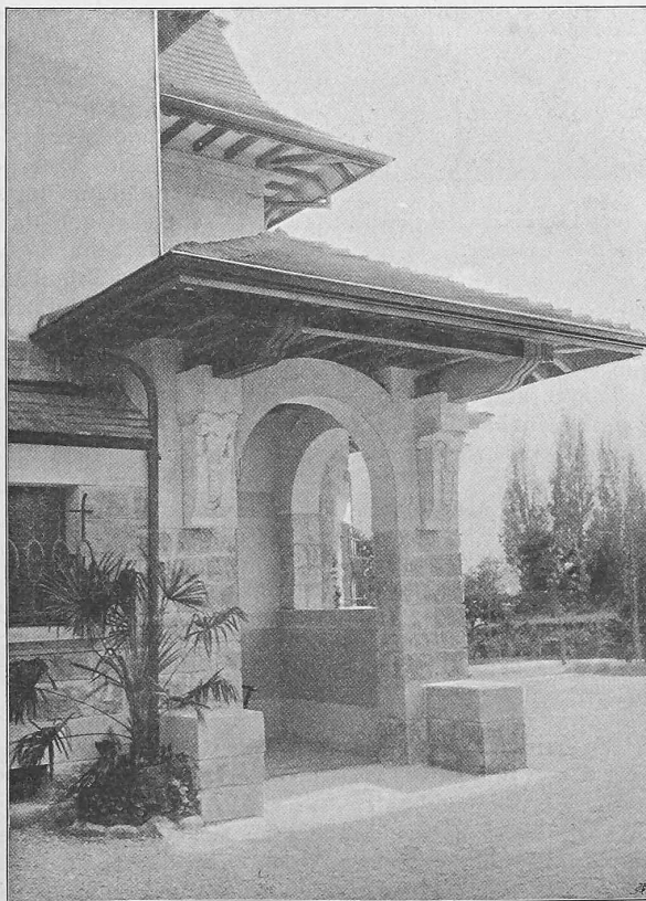
Fig. 39. Le porche d'entrée de la maison Kohler.
