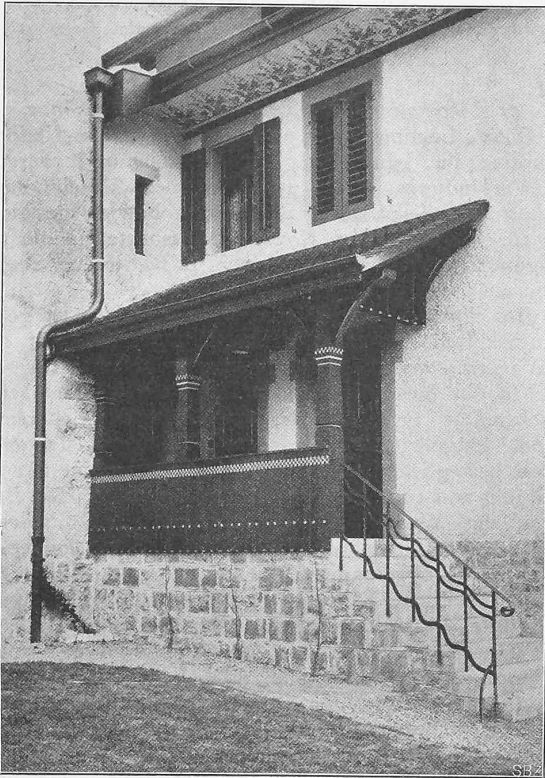
Abb. 4. Eingang zum Pfarrhaus und zur Sakristei.
