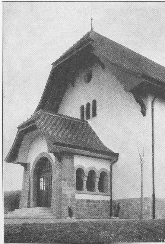
Abb. 3. Vorhalle und Giebel des Kirchenschiffs.
