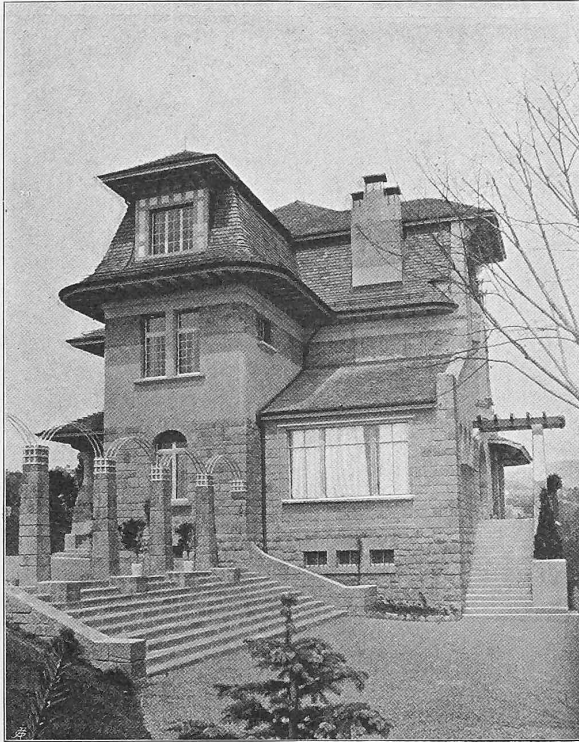
Fig. 28. La «Sauvagère» à Lausanne, propriété de M. le prof. Stilling. Architectes MM. Monod & Laverrière, Lausanne.
