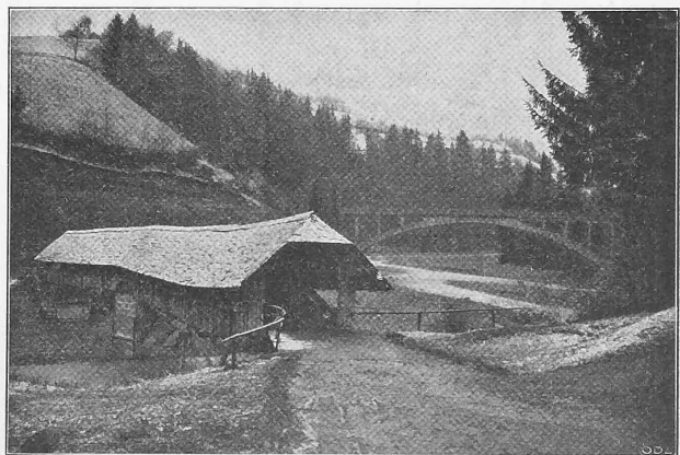
Abb. 1. Alte Holzbrücke bei Guggersbach.
