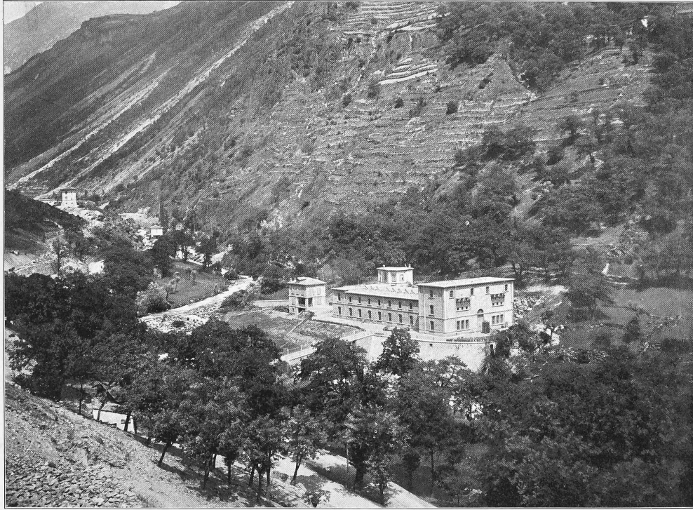
Die Kraftwerke Brusio und die Kraftübertragung nach der Lombardei. Ansicht der Transformatorstation Piattamala von Süden gesehen.
