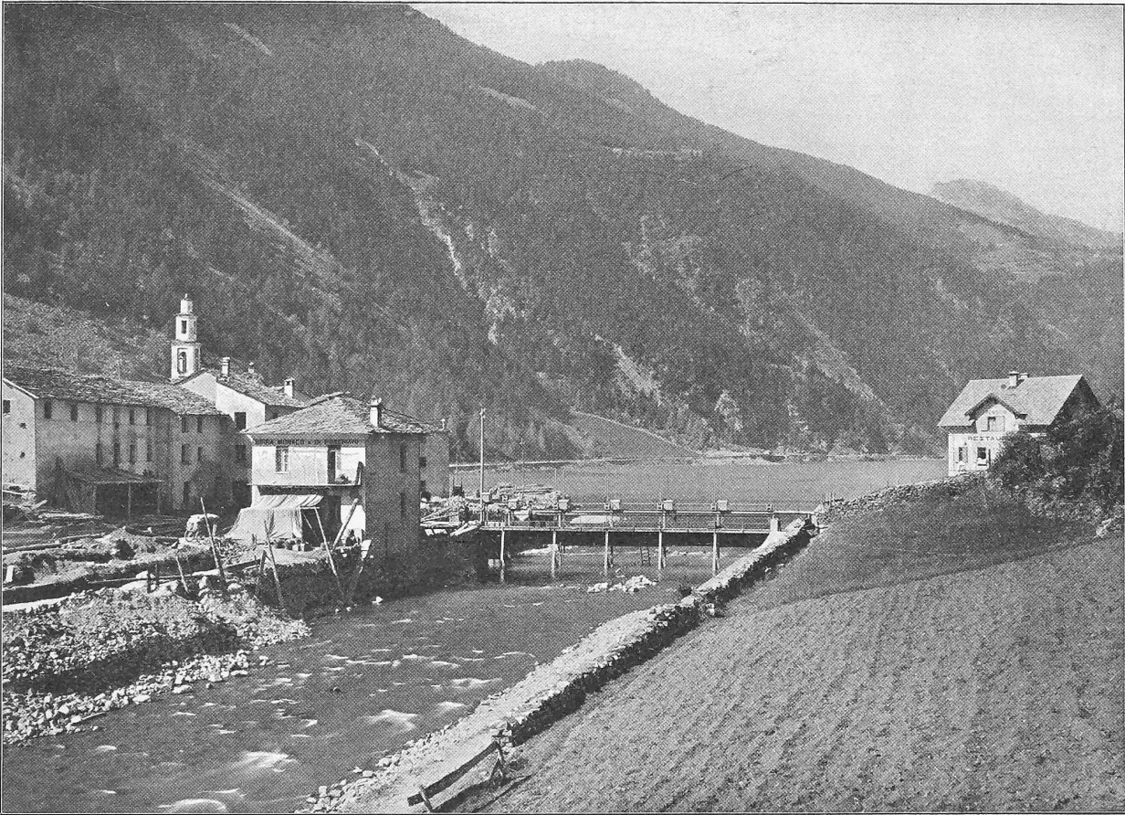
Abb. 3. Stauschleuse beim Austritt des Poschiavino aus dem See.
