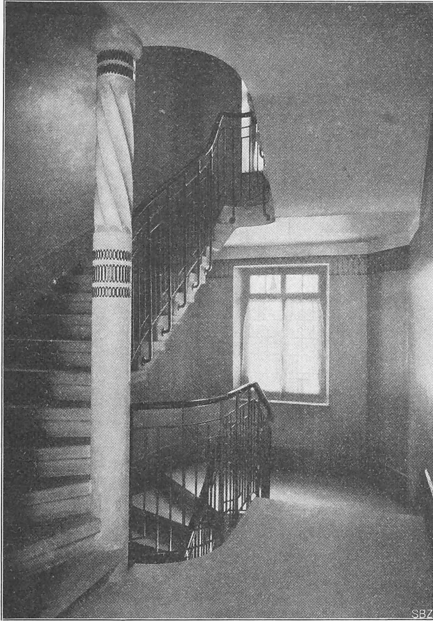
Abb. 7. Blick in das Treppenhaus.
