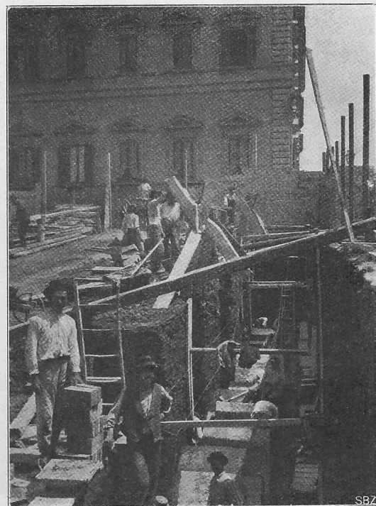
Abb. 20. Mauern der Fundamentbögen über den Pfeilern.
