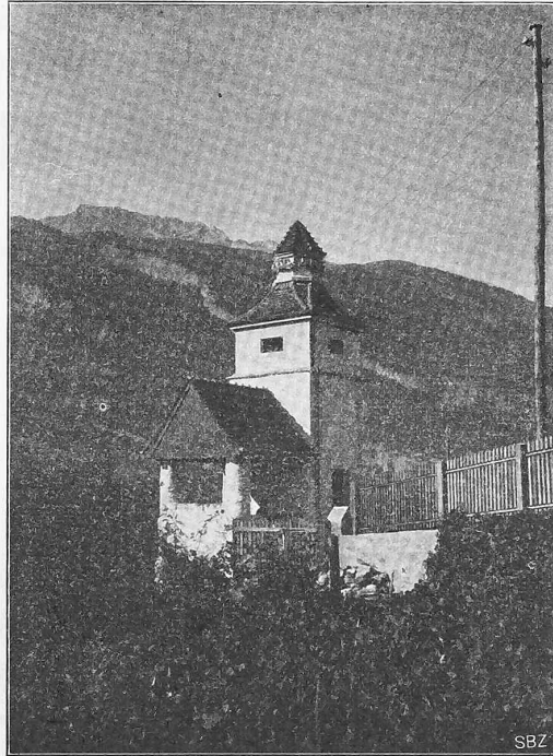
Abb. 1. Transformatorhäuschen ausserhalb der Stadt.
