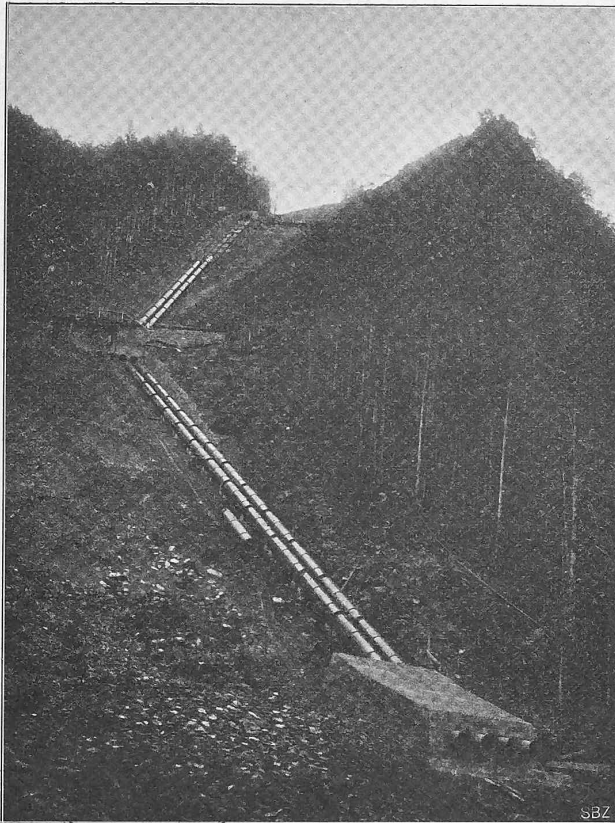
Abb. 21. Ansicht der Druckleitung zwischen den Fixpunkten S II und S IV. talen Geraden, die durch den Winkelpunkt der Tracéachse geht und deren Winkel im Grundriss halbiert.
