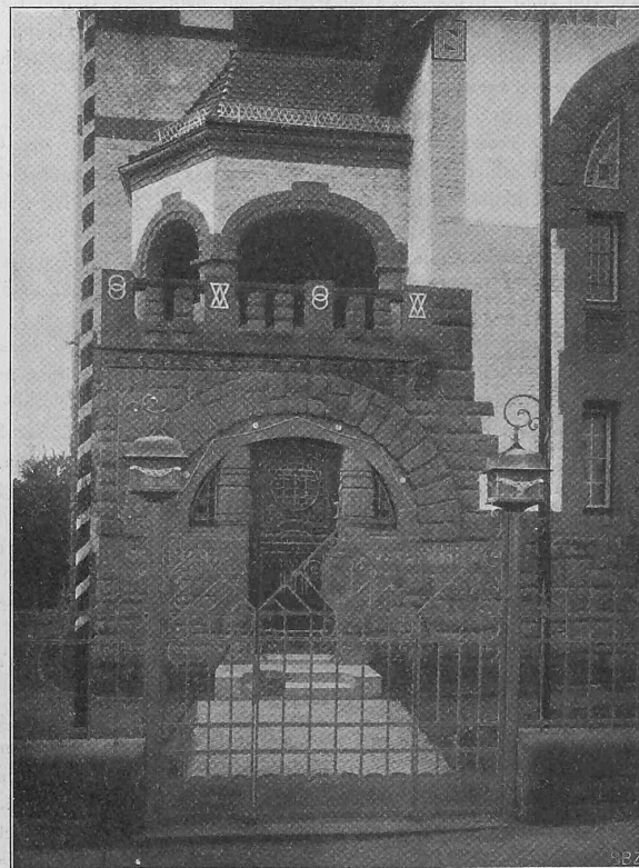
Abb. 3. Ansicht des Haupteingangs
