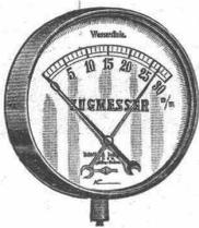
mit Zeigerskala, und mit graphischer Darstellung zur Orientierung und Kontrolle der Zugstärke in Kanälen, Röhren, Schächten, Feuerzügen etc.
