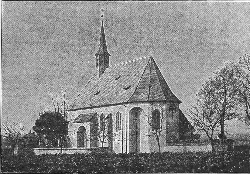
Abb. 3. Ansicht der Kirche von Nordost.
