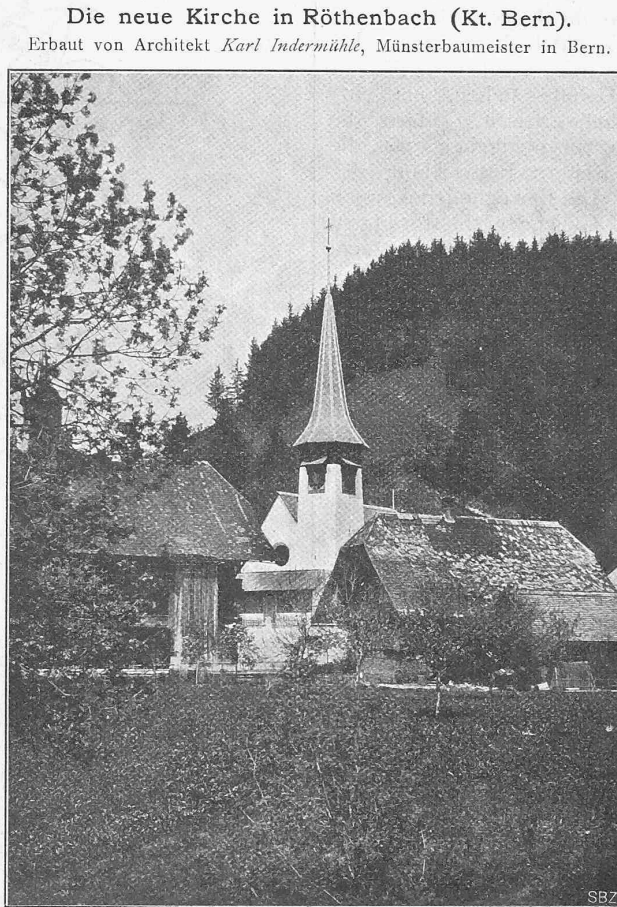
Abb. 7. Ansicht von Süd-Osten.
