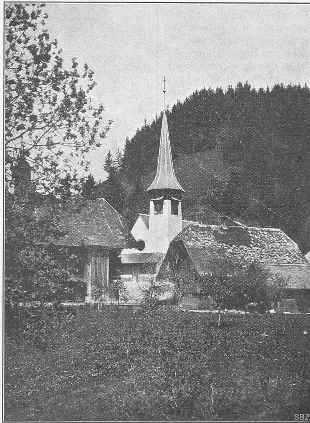
Abb. 7. Ansicht von Süd-Osten.
