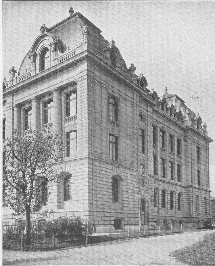
Abb. 12. Ansicht der östlichen Seitenfassade des Gebäudes.
