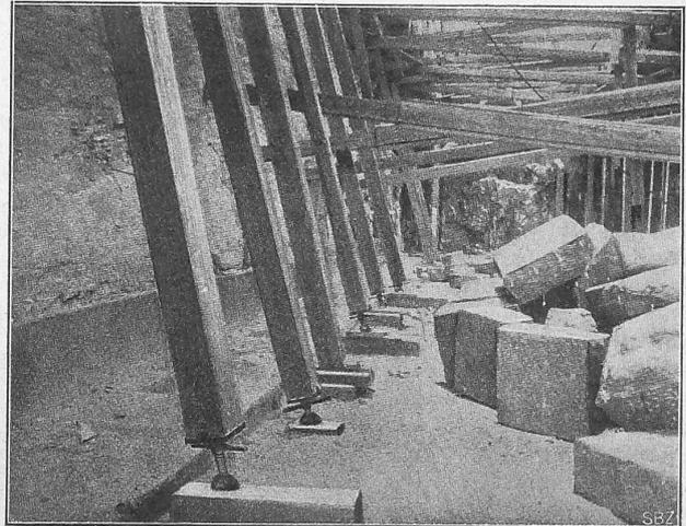
Abb. 17. Anwendung ausziehbarer Spriessen.
