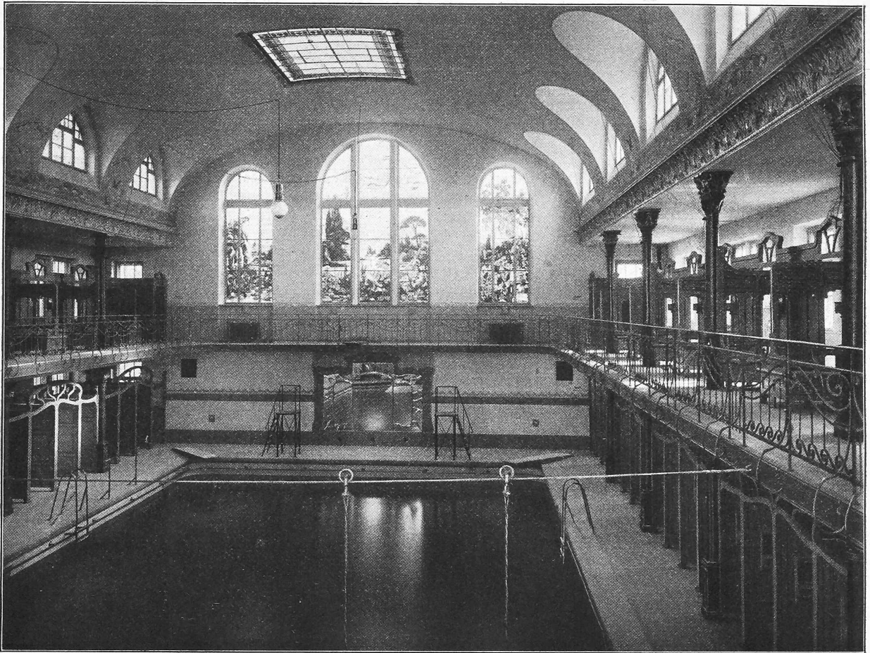
Abb. 11. Blick in die Männerschwimmhalle gegen Osten.
