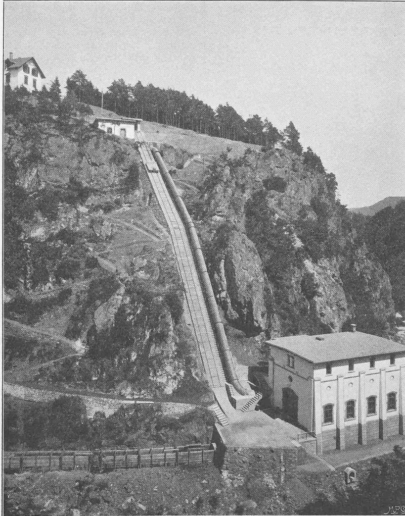
Abb. 15. Ansicht der Kraftzentrale Hohenfels.
