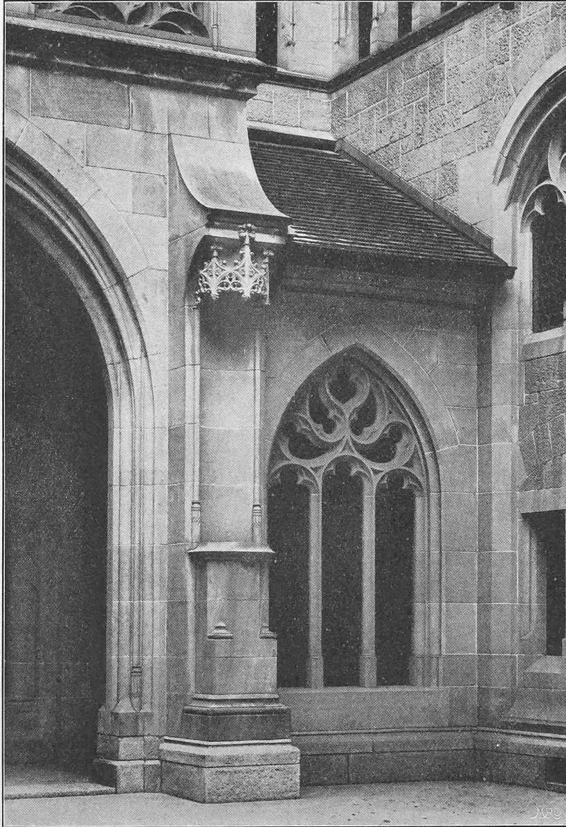
Abb. 26. Baldachin am Strebepeifer des Ostportals in Hof II.
