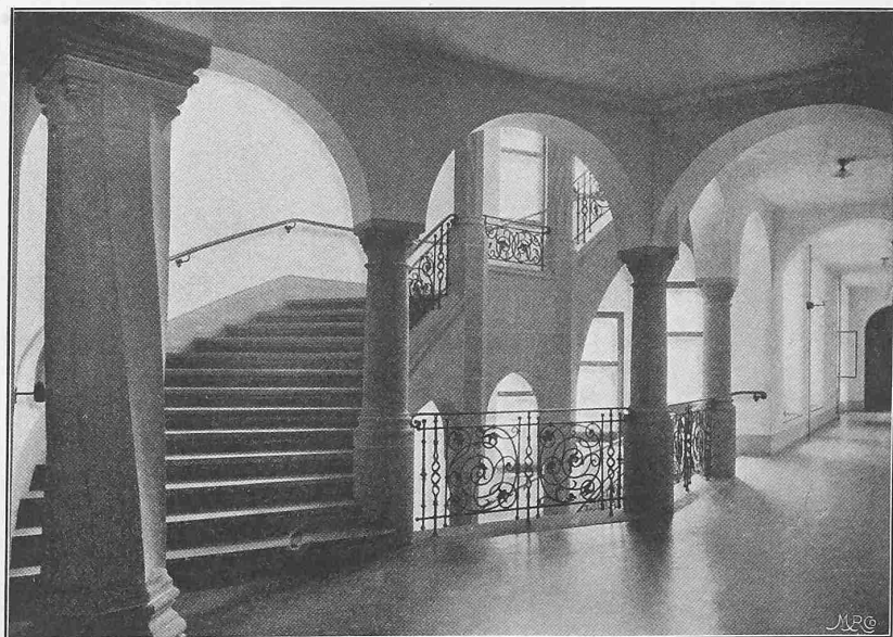
Abb. 16. Treppenhaus im Westflügel.
