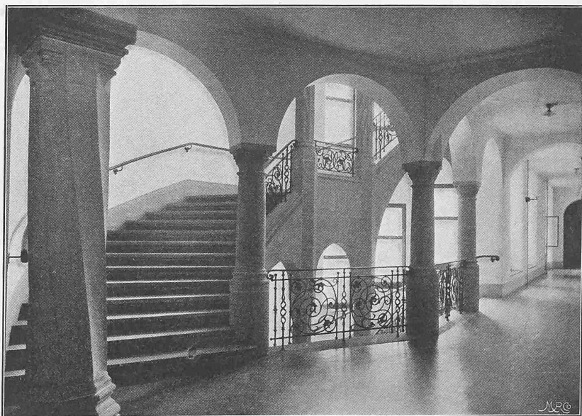
Abb. 16. Treppenhaus im Westflügel.
