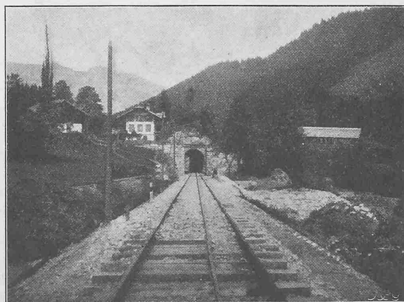
Abb. 16. Das obere Portal des Lehtunnels.
