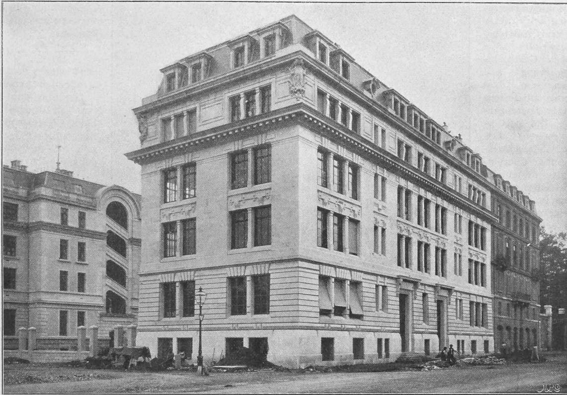
Fig. 7. Ecole primaire des Casemates à Genève. — Architectes: MM. L. & Fr. Fulpius. — Vue depuis la rue des Casemates.
