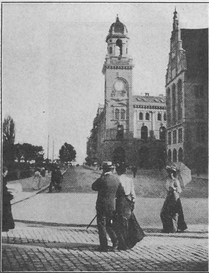
Abb. 8. Ansicht von Norden.
