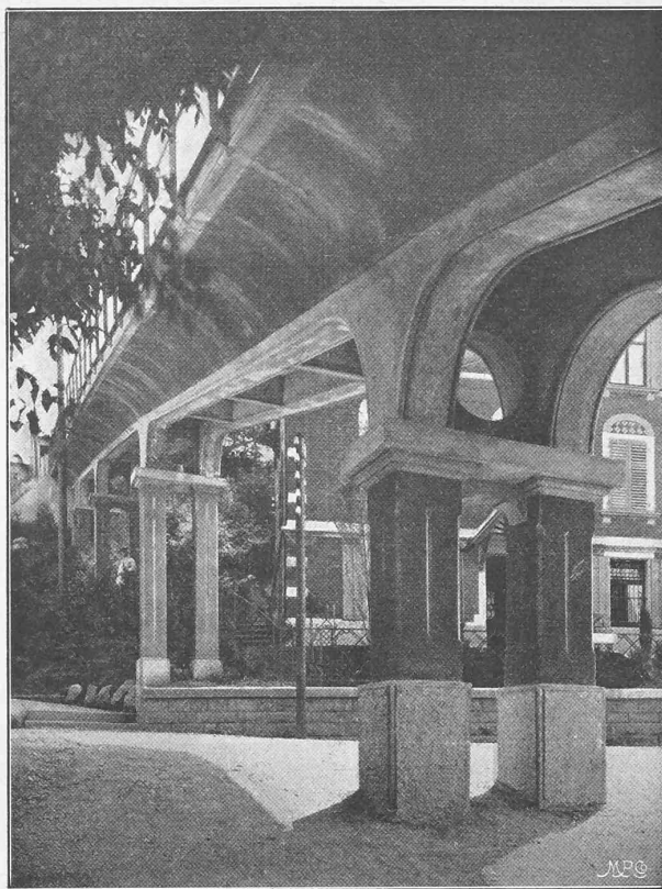
Abb. 8. Die Hadlaubbrücke. — Unterführung der Hadlaubstrasse.
