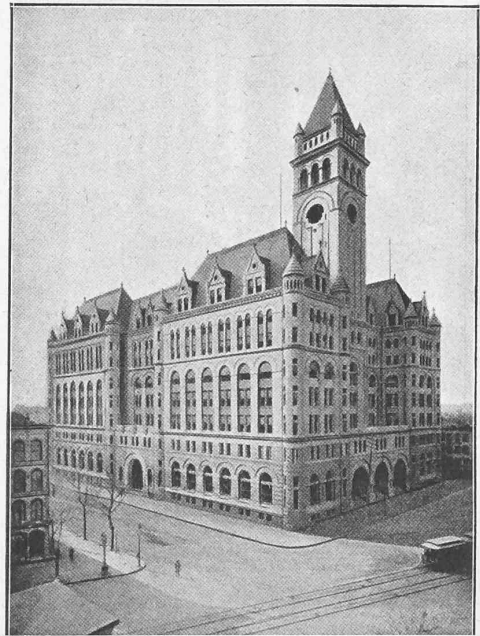
Abb. 36. Washington. — Das Postgebäude.
