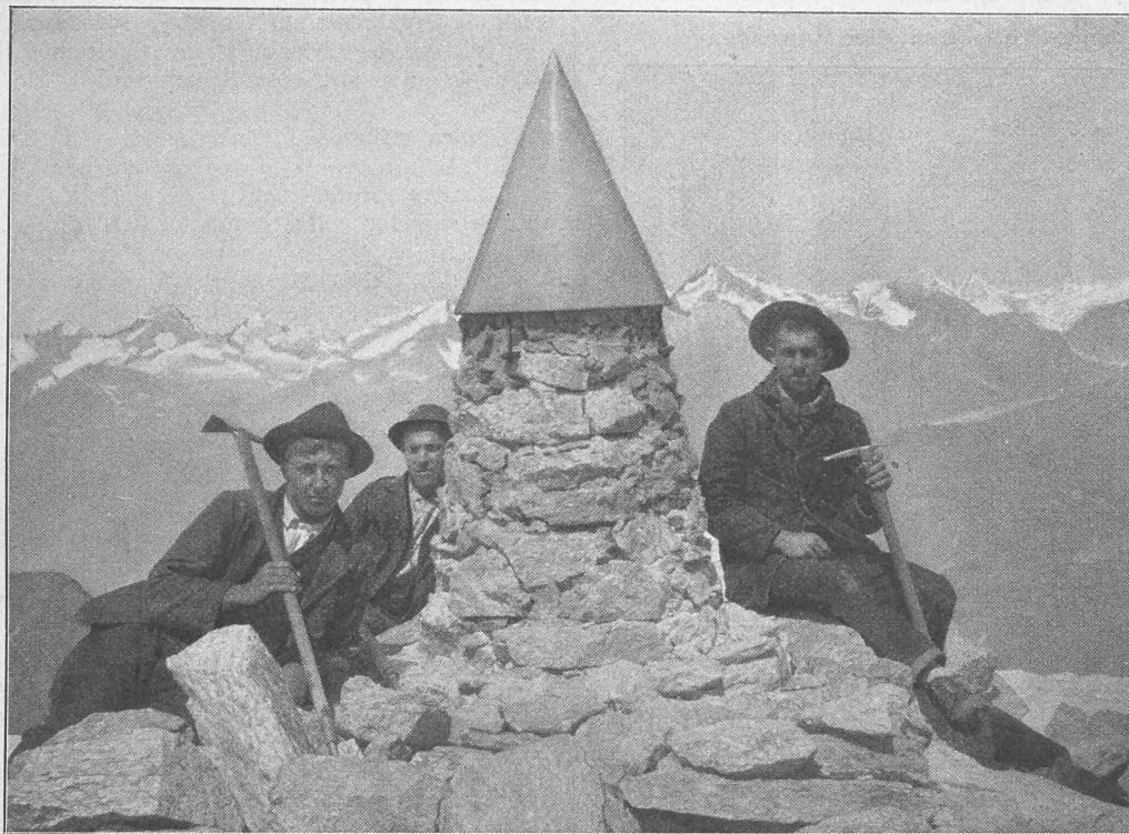
Fig. 6. Trigonometrisches Signal auf dem Monte Leone.
