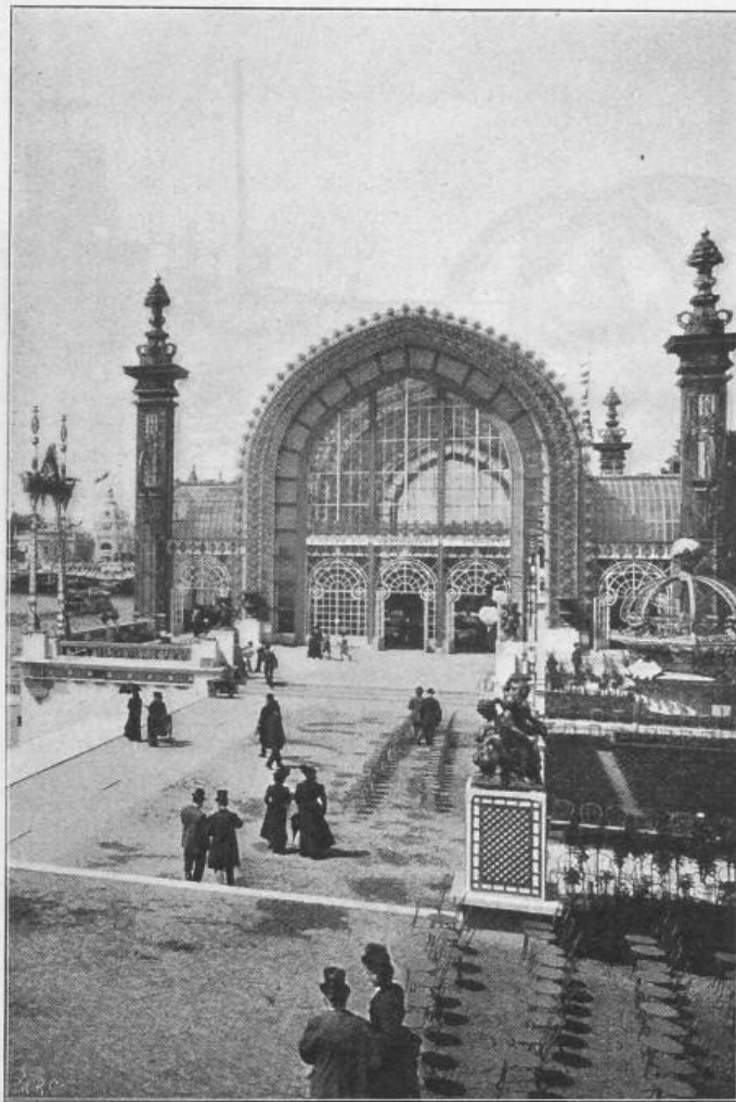
Fig. 28. Gewächshaus am rechten Seine-Ufer.
