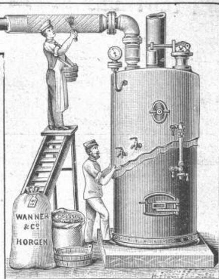
Komplete Isolierungen an Dampf- und Heizungs-Anlagen zum Schutze gegen Wärmeverlust, sowie an Wasserleitungen zum Schutze gegen Einfrieren führen wir fachgemäss, wirkungsvoll und prompt durch geübte Specialarbeiter aus. — Ausführlicher Katalog und Kostenvoranschläge gratis und franko.
