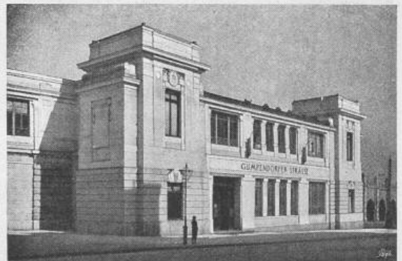
Fig. 6. Wiener Stadtbahn. Haltestelle Gumpendorfer-Strasse.
