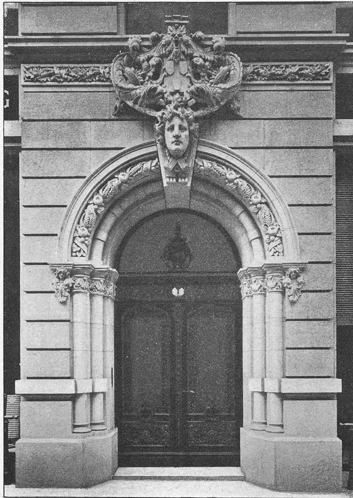
Fig. 1. Portal von dem Wohnhause Marschallstrasse I in Dresden.
