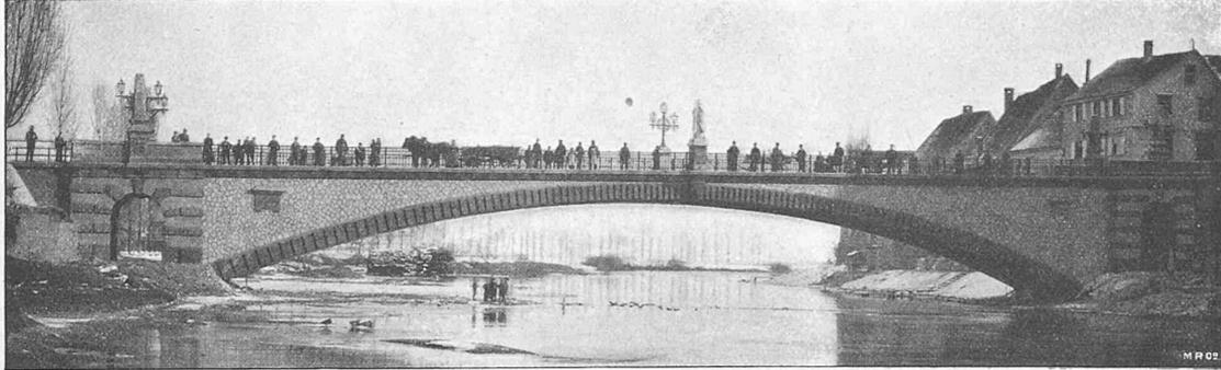
Fig. 38. Stampfbeton-Brücke über die Donau bei Munderkingen.
