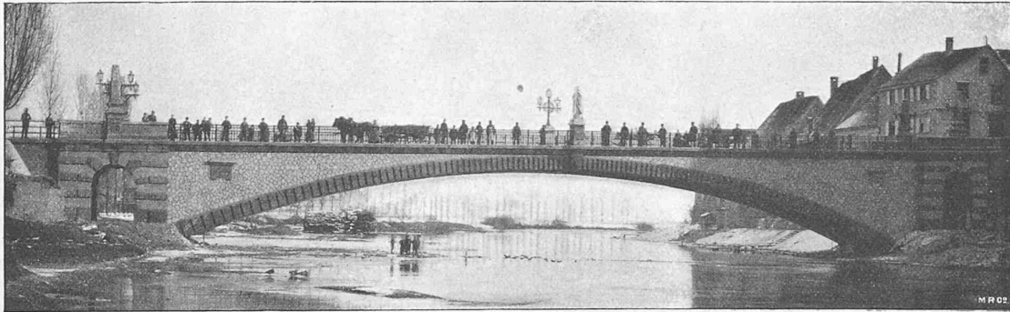
Fig. 38. Stampfbeton-Brücke über die Donau bei Munderkingen.
